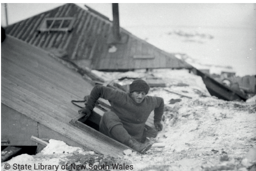
Xavier Mertz verlässt die Schutzhütte durch das Dachfenster.
